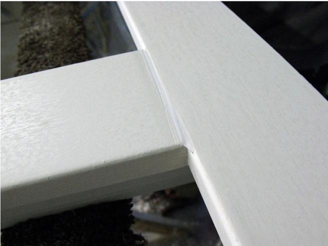
Der Induline AF-920 von Remmers ist für das Verschließen von Gehrungsfugen geeignet.
